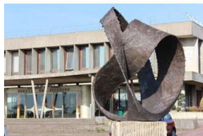
Beaulieu Bât1A Entrée principale
